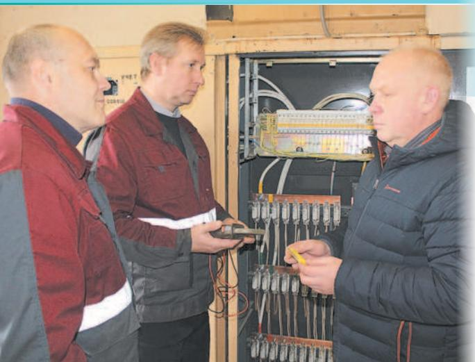
**Ч**ТОБЫ свет в домах не погас, а бытовые электроприборы не сгорели, электрики Управдома Заволжского района регулярно проводят профилактические обходы подъездов, ревизуют щиты и вводные распределительные устройства (ВРУ), контролируют светильники, выключатели и электропроводку. По результатам обследований составляются акты с перечислением выявленных дефектов для их скорейшего устранения.
