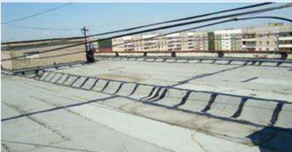
В текущем году мы планируем ремонт порядка 20 кровель с применением новых технологий. Это установка так называемой мембранный кровли, когда новая крыша на полиуретане крепится прямо к старой кровле. Полотнища между собой свариваются. Такая кровля «дышит», но вода не проникает внутрь. Увеличивается и срок ее эксплуатации – до 20 лет, и очень удобно ее ремонтировать. К работам по ремонту крыш планируем приступить сразу, как растает снег.
