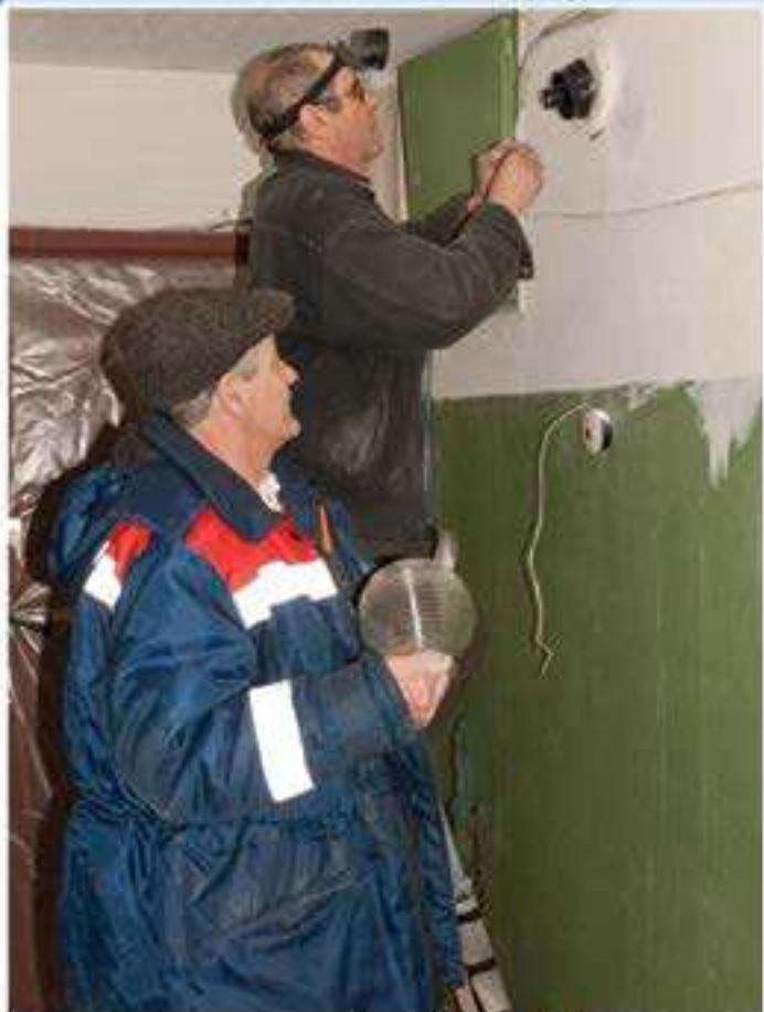
№ 16/10 по улице Комарова. В этих домах теперь проведена проводка, отвечающая самым современным требованиям – пятижильные медные провода, которые прослужат намного дольше, чем алюминиевые, установлены новые автоматические выключатели, УЗО (устройства защитного отключения) и так далее.
