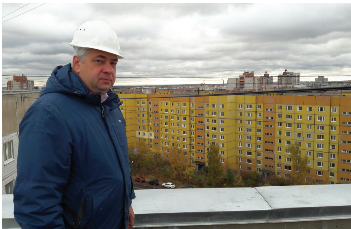
Главный инженер Управдома Заволжского района Александр Волков на объекте капитального ремонта – кровле многоквартирного дома / фото автора
