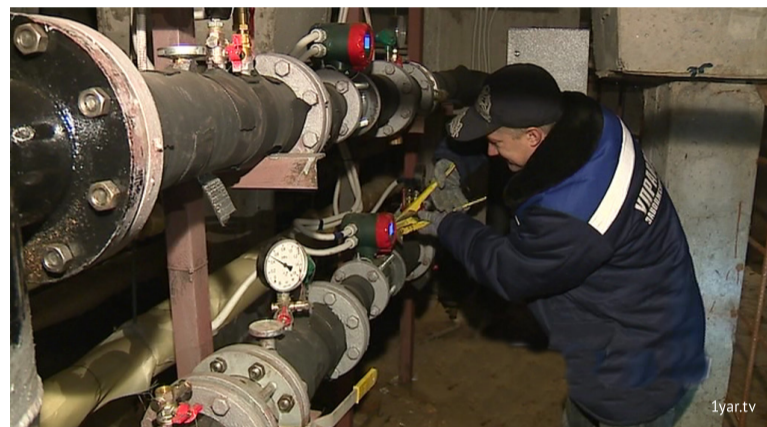
Система теплоснабжения на улице Серго Орджоникидзе, 26 отремонтирована быстро и, по мнению жителей, с отменным качеством
