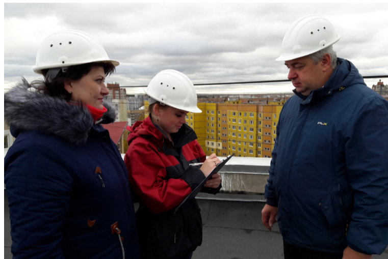
Служба технадзора Управдома Заволжского района контролирует кровельные работы
