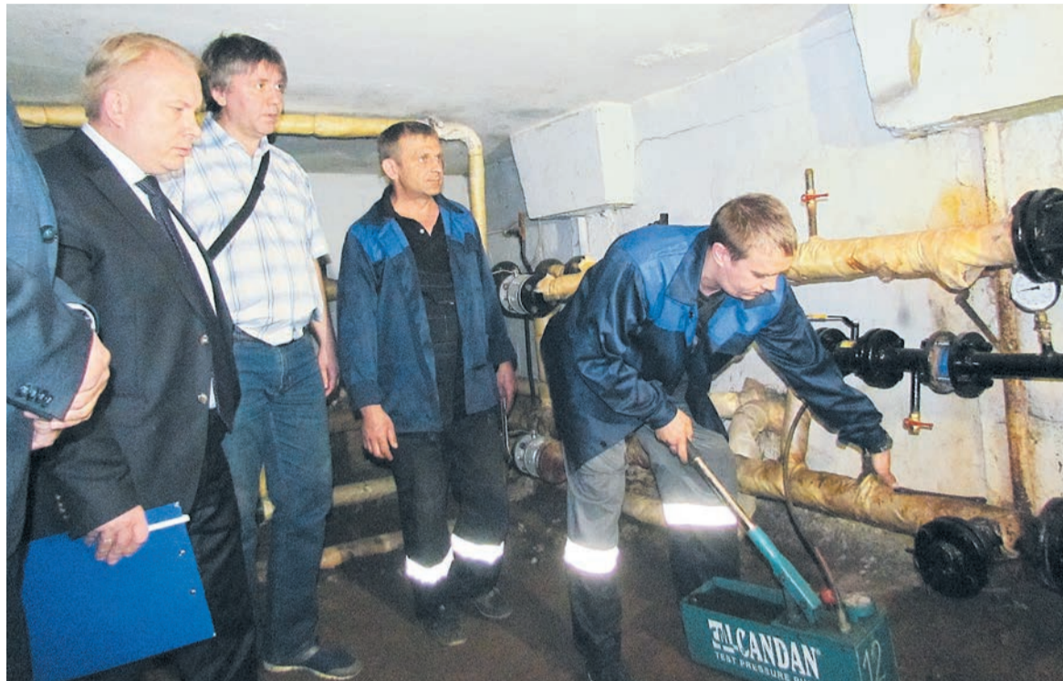
Представители «Народного контроля» инспектируют опрессовку теплоузла на улице Папанина. Замечаний нет
