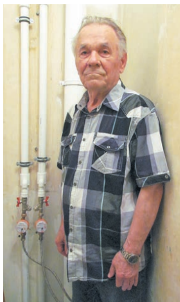
Ветеран труда Н. М. Сахаров доволен качеством недавнего капремонта трубопроводов в его квартире на ул. С. Орджоникидзе в Заволжском районе Ярославля
