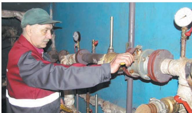
Опытный слесарь-монтажник Виктор Валентинович Окружнов готовит систему к промывке
