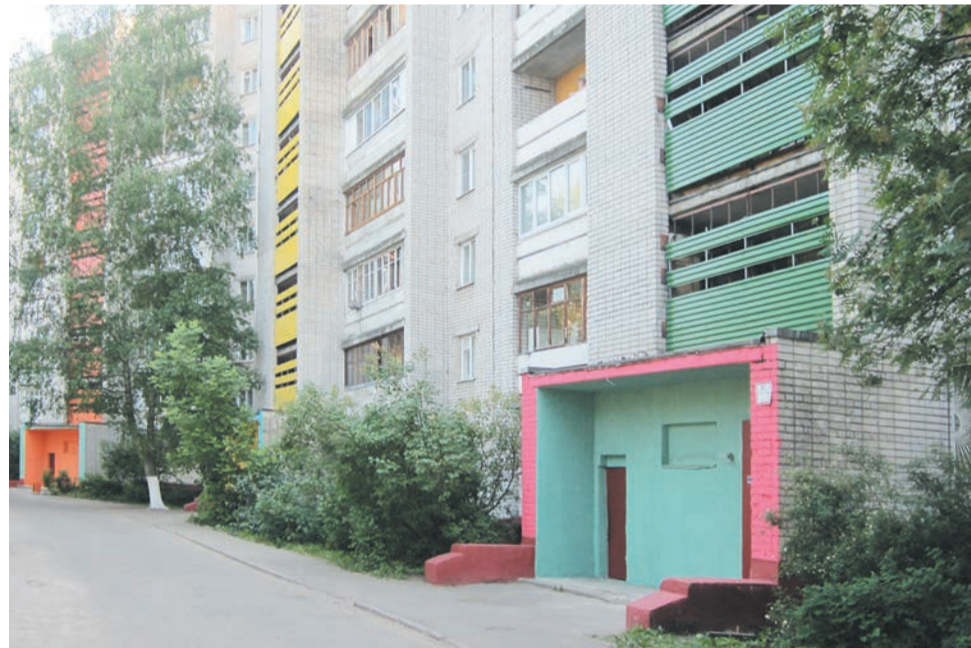
Отремонтированные фасады обшиты цветным нержавеющей металлом и «одеты» в цветную шубу – как, например, у дома 63 корпус 5 по улице Ньютона (этот дом в народе называют радужным, все семь его подъездов соответствуют цветам радуги)
