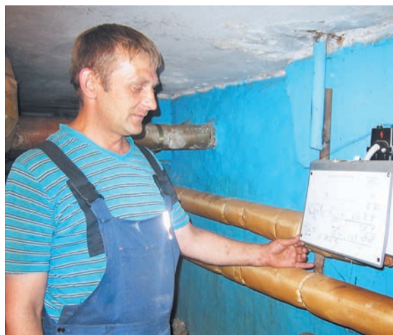
Монтажник внутренних сантехнических работ Александр Бурмистров у схемы теплоузла дома
