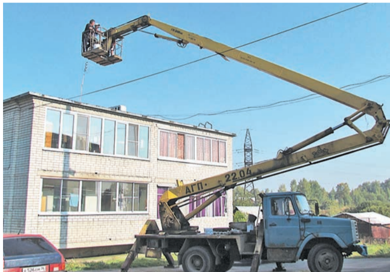
Так Управдом ведет текущий ремонт кровель
