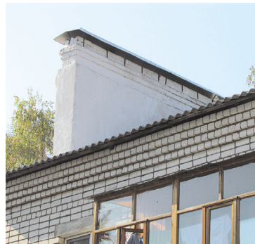
Качественный ремонт крыши в Толге.
