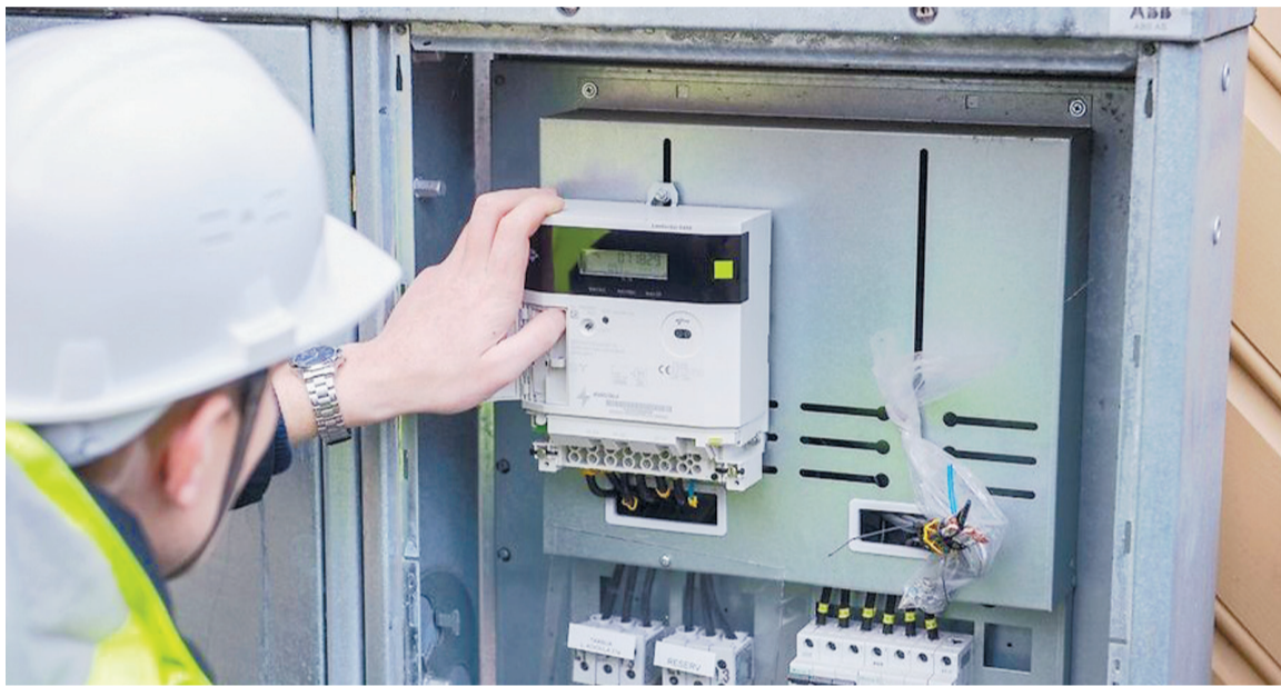
Установка автоматизированной системы АСКУЭ поможет жителям сэкономить на оплате ОДН.
