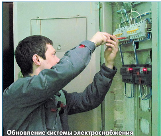
Обновление системы электроснабжения
