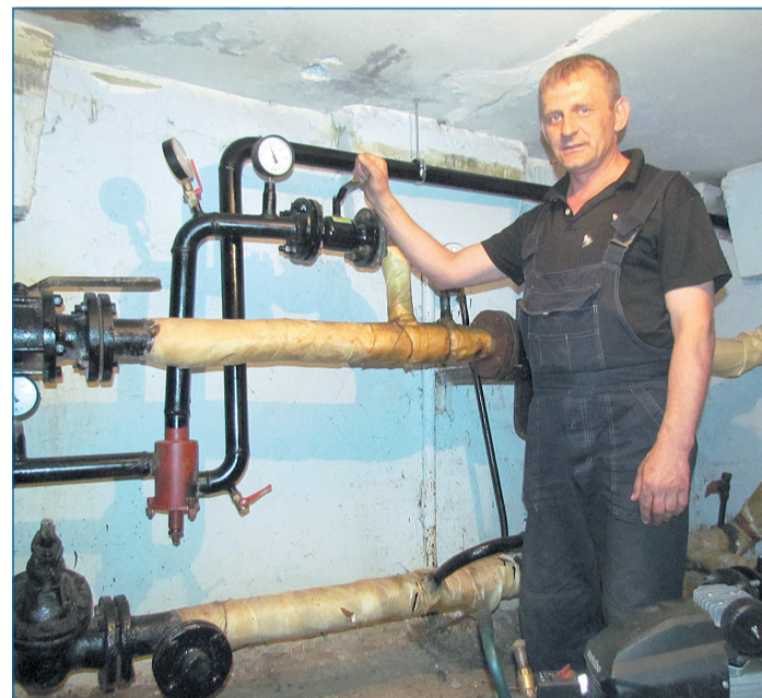
Слесари сантехслужбы Управдома Заволжского района А. И. Хомин и А. В. Бурмистров готовят к гидравлическим испытаниям теплоузел многоквартирного дома на улице Папанина, 13.
