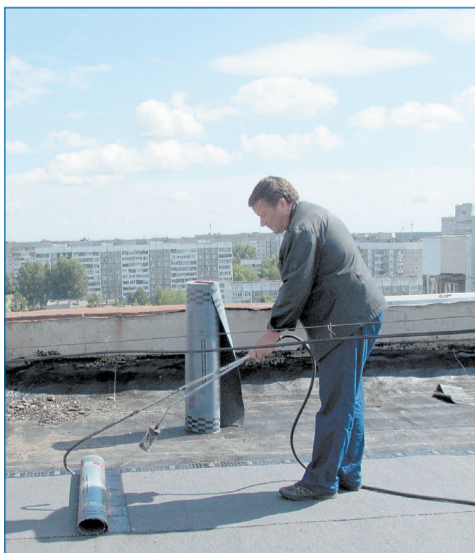
Укладка нового кровельного материала.
