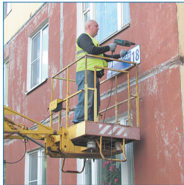
Установка нового аншлага с адресом на стене дома.
