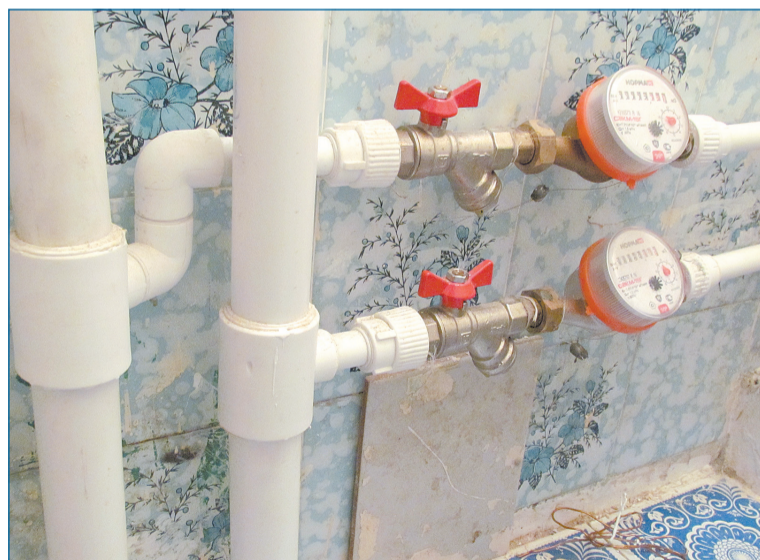
Так после капремонта выглядят новые пластиковые трубопроводы в квартирах.
