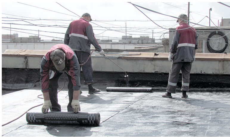
Продолжаются ремонты кровель многоквартирных домов Управдома Заволжского района.
