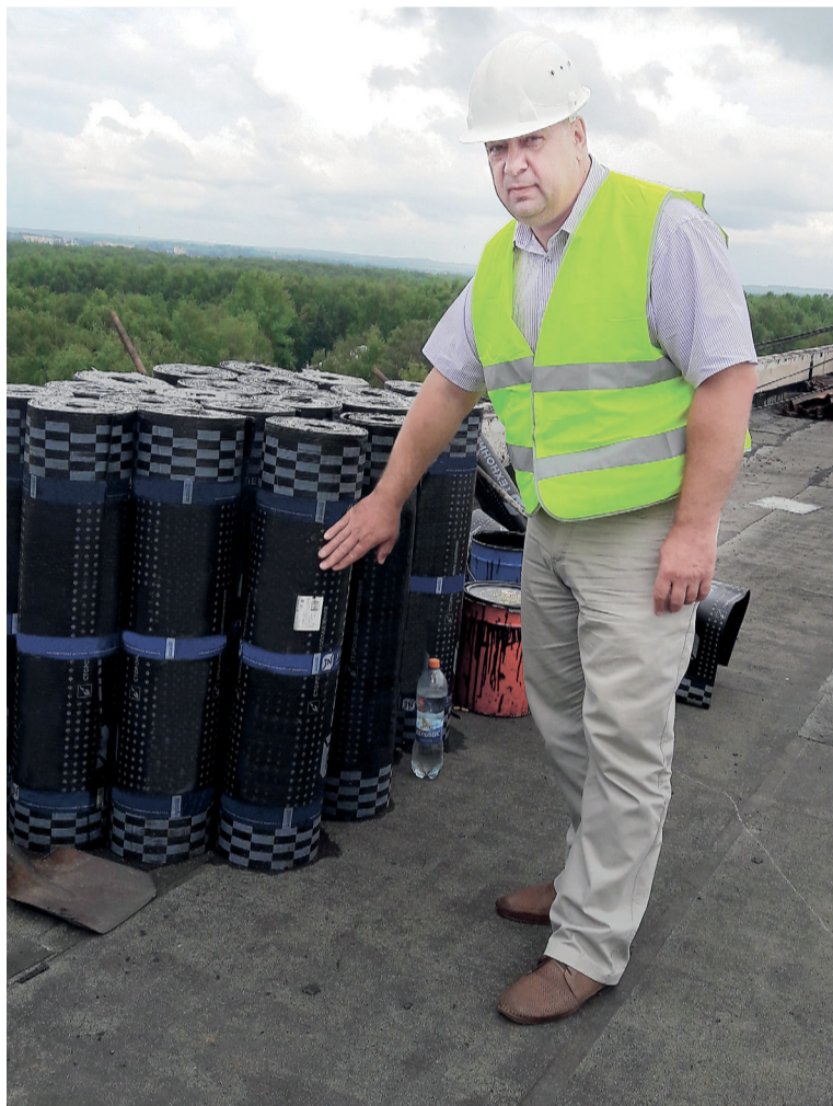
Главный инженер Управдома Заволжского района А.В. Волков проверяет качество ремонта кровли
