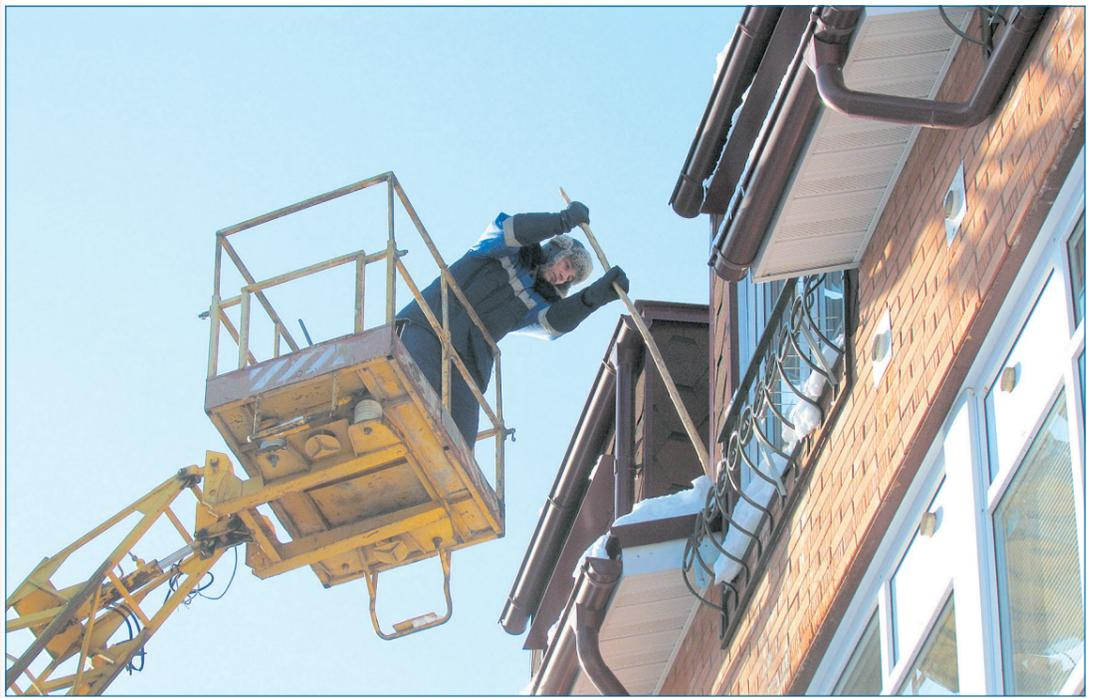
Кровельщик Антон Печаткин в составе специализированной бригады очищает от снежных свесов сложную кровлю нового многоквартирного дома на ул. Клубная, 26.
