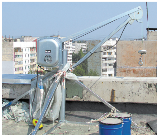
Удобный подъемник облегчает труд кровельщиков.
