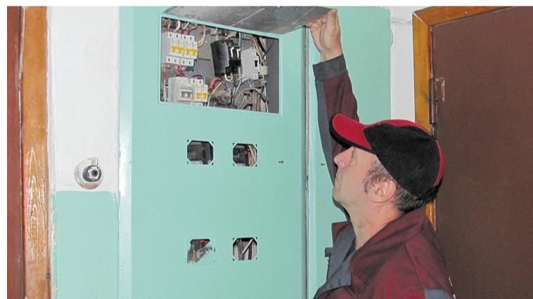
В обновленном подъезде пятиэтажного жилого дома на проспекте Машиностроителей, 2а электрик Управдома Заволжского района Игорь Мамонов завершил плановые работы по замене выключателей, фонарей освещения и ремонту проводки.
