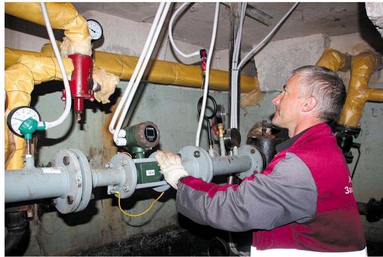
Слесарь-монтажник сантехоборудования Михаил Фролов готовит систему к промывке.
